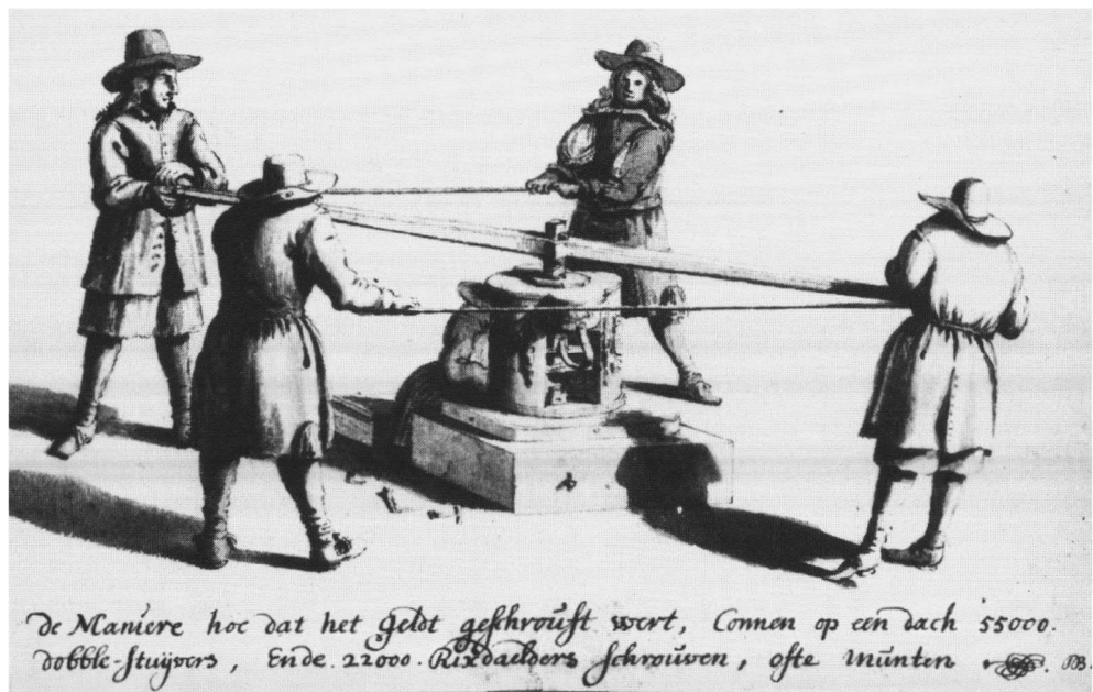
‘De Maniere hoe dat het gelt geschroeft wert, Connen op een dach 55000 dobbel-stuijvers, ende 22000 Rixdaelders schrouwen, ofte munten’. Daniël de Blieck; tekening van de muntpers uit 1671
