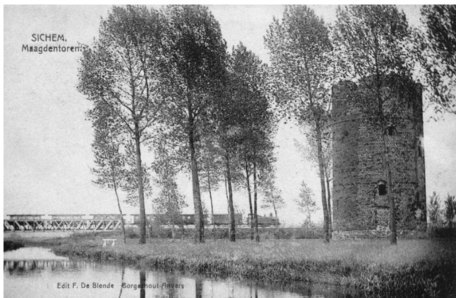
Zicht op de Maagden- of Markentoren met op de achtergrond de treinverbinding Diest-Aarschot (1898). Na de instorting op 1 juni 2006, is de Vlaamse overheid bezig met de renovatiewerken. 10
